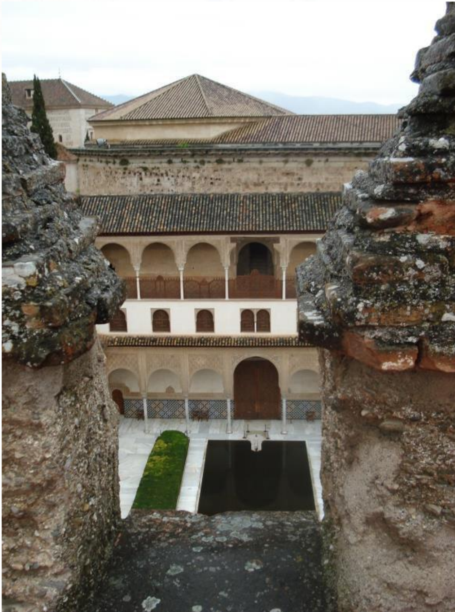
FIGURA 4 Muro Sur del patio de la alberca del palacio de Comares.
